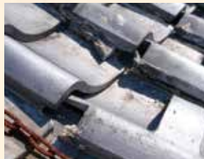
屋根瓦のズレ・破損
