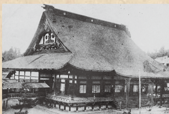
昭和22年焼失の二十間四面の本堂
