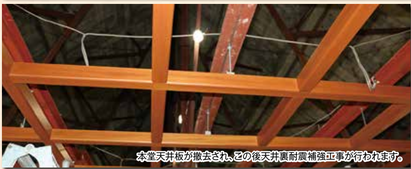
耐震工事のため本堂には足場が組まれました。
